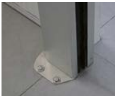
Detalle de fijación al suelo
