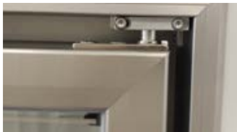
Fijación superior de la puerta con regulación
